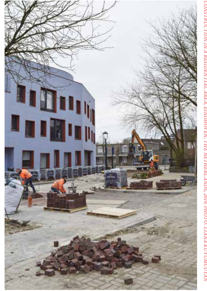
KONUT BÖLGESİNDE BİR İNŞAAT. EINDHOVEN, HOLLANDA, 2019. FOTOĞRAF: LIANA KUYUMCUYAN CONSTRUCTION IN A RESIDENTIAL AREA, EINDHOVEN, THE NETHERLANDS, 2019. PHOTO: LIANA KUYUMCUYAN
